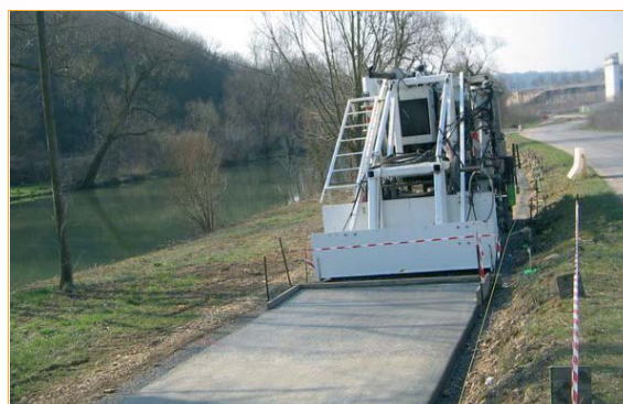
Le traçage du ruban de béton...
