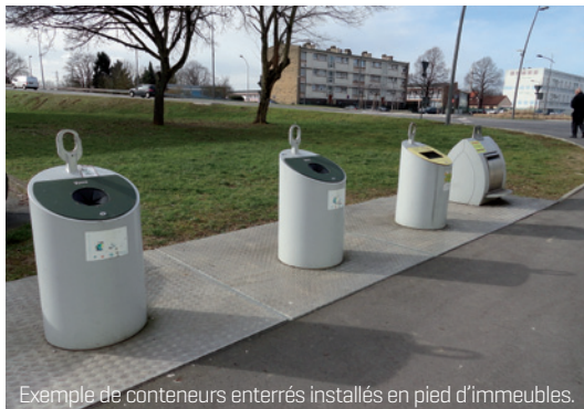
Exemple de conteneurs enterrés installés en pied d'immeubles.
