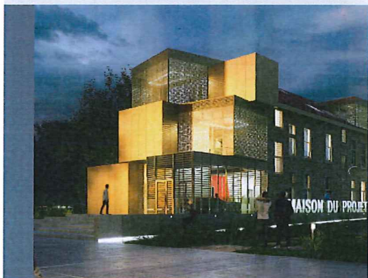
Amenagement de la maison du projet dans l'ancienne maison de syndicats.
