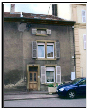
Avant réalisation des travaux
