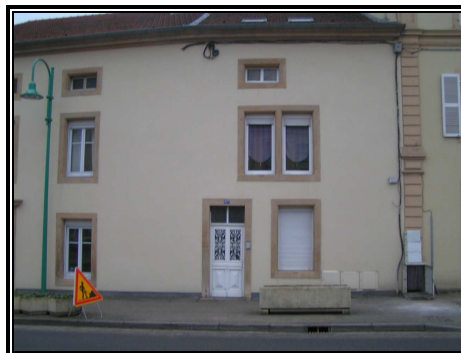
Après réalisation des travaux
