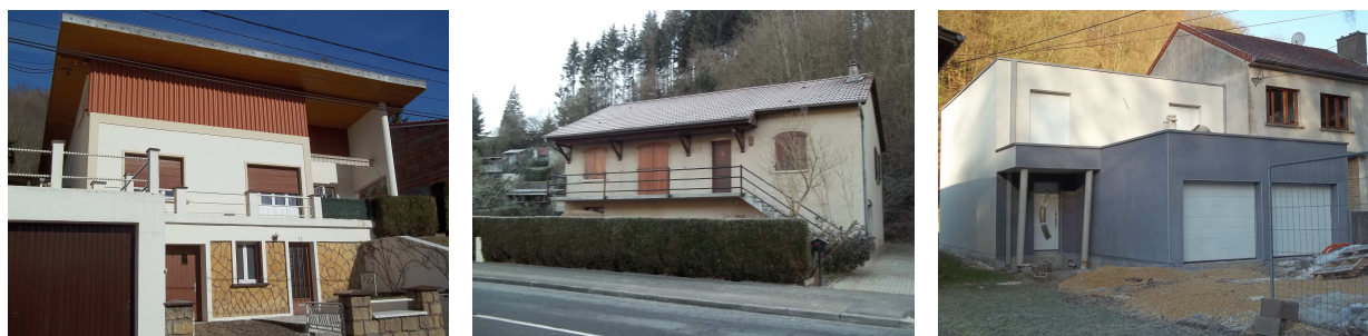
Exemple d'habitats contemporains situées à MOYEUVRE-PETITE Source : Cabinet MANGIN
