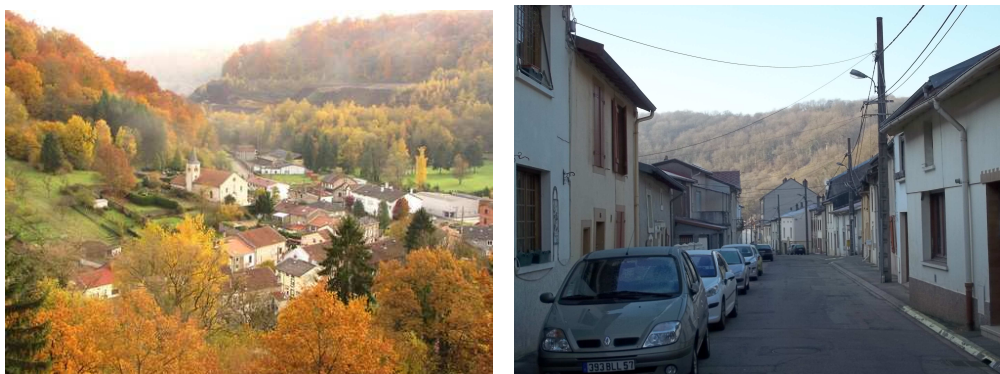
à gauche, vue depuis le calvaire – à droite, vue depuis la Grand'rue Sources : Michel HENRY et Cabinet MANGIN
